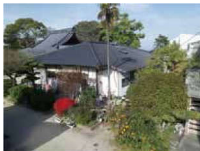
〈解体前の庫裏の様子〉
